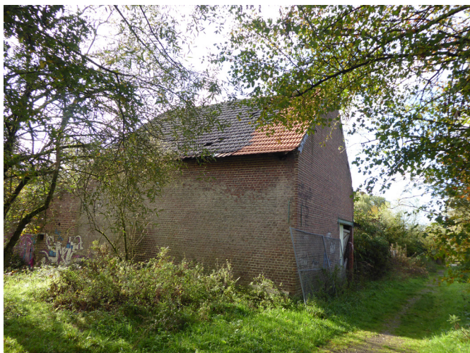
(1) E99k - Grange de la ferme du Meylemeersch
